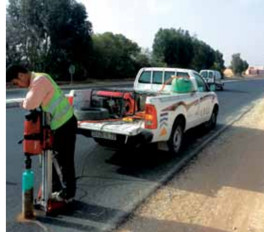
Carottage de la couche de roulement.
