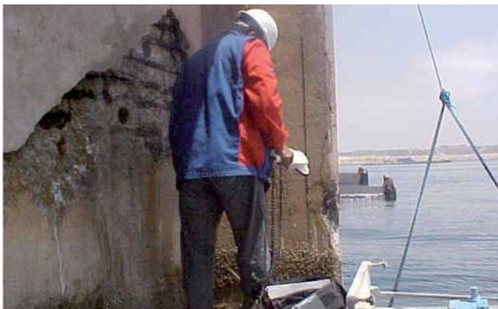
Réparation de dégradations causées sur l'ouvrage par l'environnement.
