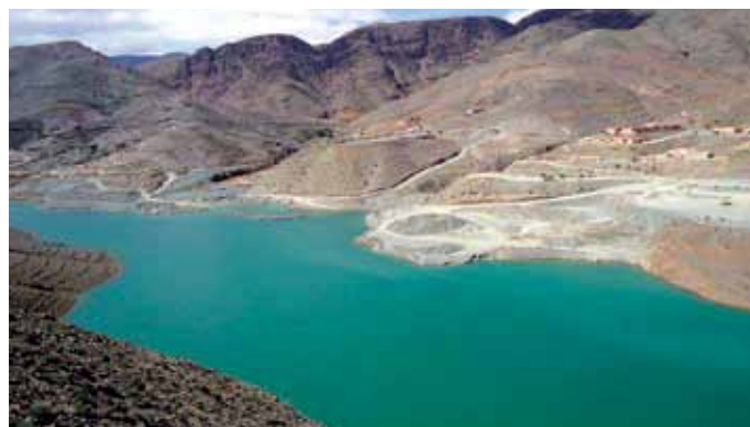
Une vue du barrage Taskourt.
