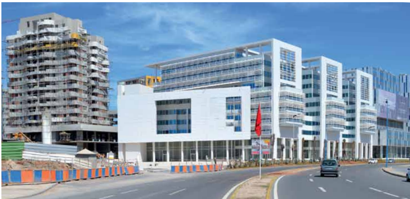
Le béton utilisé dans la construction de la Marina de Casablanca obéit à la norme NM 10.1.008
